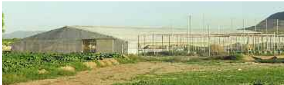
Figura 3. Detalle de un invernadero tipo capilla con estructura de palos metálicos en su interior, en este caso, propiedad del IMIDA, en Torre Blanca (Término municipal de Torre Pacheco).
