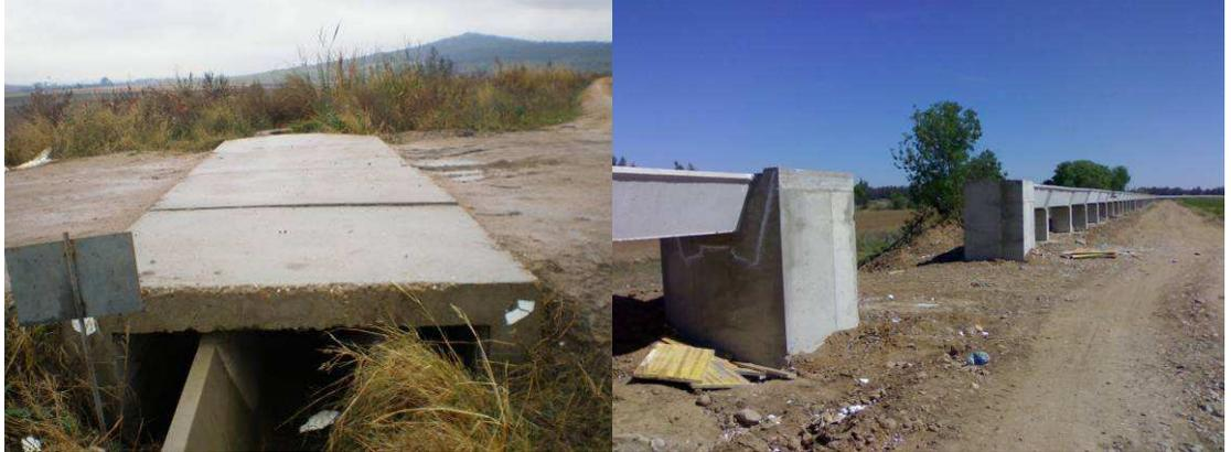
*Figura ii. Detalle de pasos de losa prefabricada sobre acequia o sifón para acceso de maquinaria a la parcela.*
