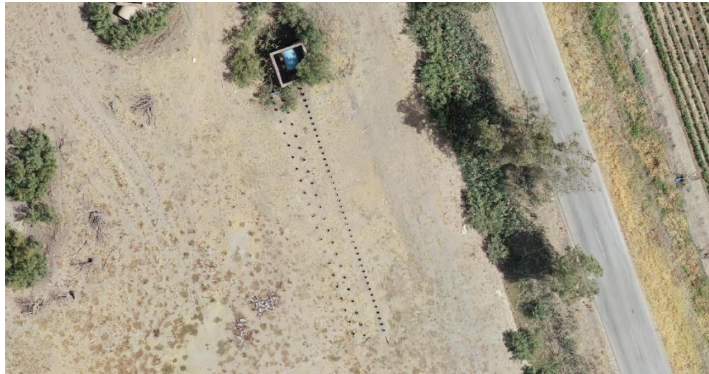
Imagen 1. Vista general de la estación de filtrado.
