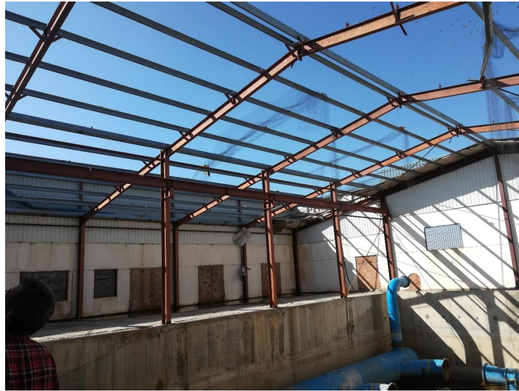
Imagen 8. Estructura metálica y cubierta. Vista interior de la estación de bombeo principal.
