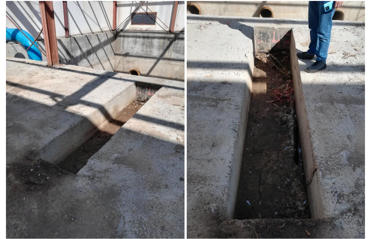
Imagen 10. Huecos ejecutados en solera de la estación de bombeo principal.
