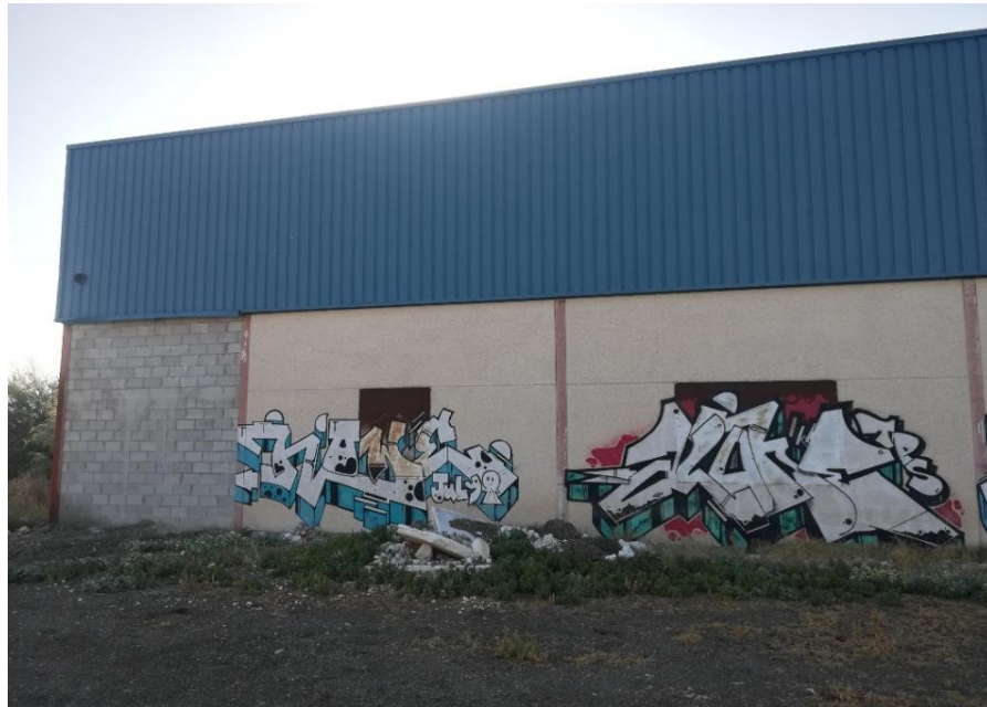
Fotografía 2: Vista exterior del estado de la fachada norte del edificio. Se observa el cerramiento de uno de los paños mediante bloques de hormigón prefabricados en lugar de los paneles prefabricados originales.
