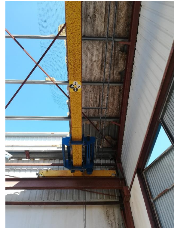
Imagen 18. Estado actual puente grúa. Estación de bombeo principal (1).
