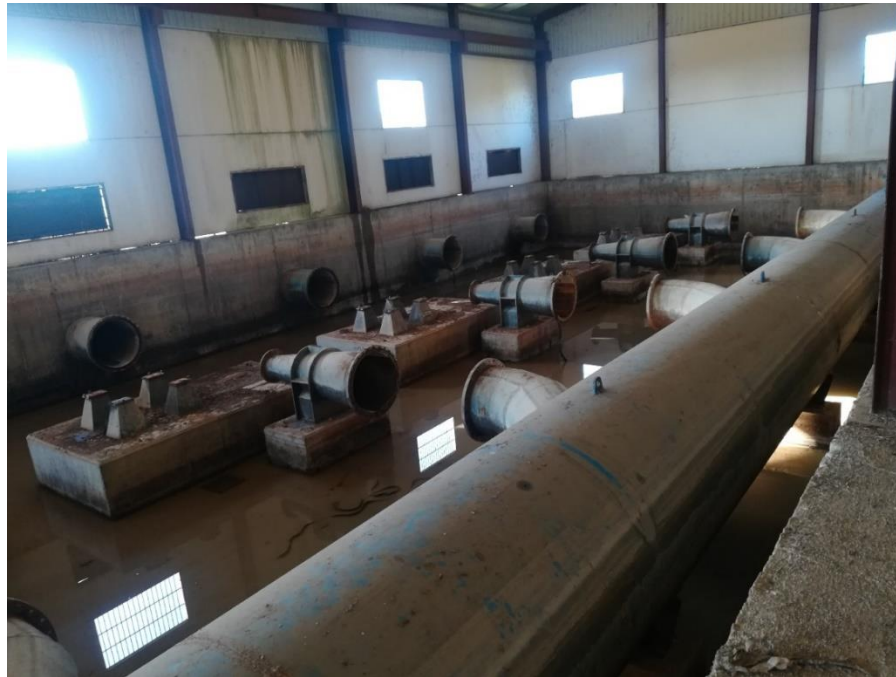
Fotografía 5: Fotos el foso de bombeo en su estado actual, con los equipos electromecánicos de la cadena de grupo de bomba desmontada (bombas, motores y valvulería) para su inspección y adecuación por taller especializado.
