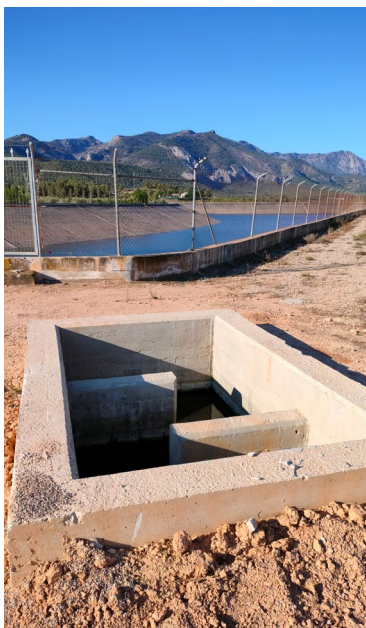
En esta imagen se visualiza el desarenador de la obra de entrada con las aguas procedentes del sondeo, la conducción de entrada es de 500 mm de diámetro (a renovar).
