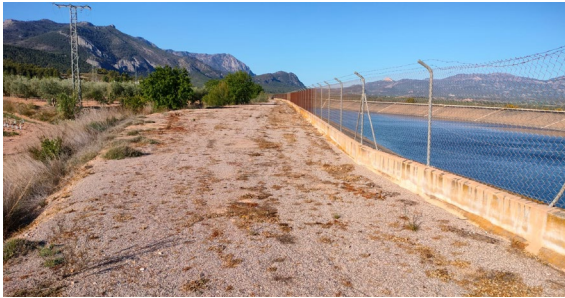
En esta imagen se visualiza la coronación del dique, con un ancho variable.
