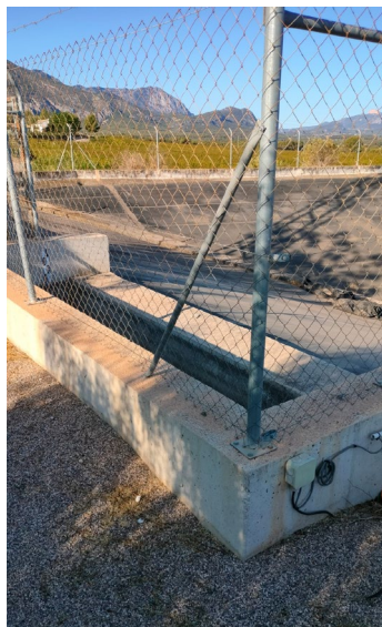
En esta imagen se visualiza la arqueta de rotura de la entrada de agua procedente del TTS, se realizará la adaptación de esta arqueta con la lámina nueva a instalar.
