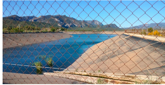
En esta imagen se visualiza el vaso del embalse, donde se ve los lastres entrada (a demoler) y la obra de entrada (a demoler) con las aguas procedentes del sondeo, y la lámina impermeabilizante EPDM existente (a desmontar).
