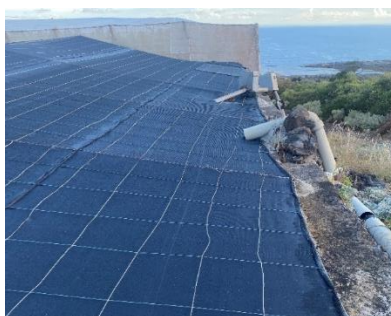
Imagen 6. Detalle de depósito existente cubierto bajo malla.
