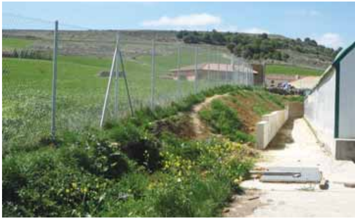
Foto 5: Se mantendrá un perímetro de, al menos, 2 metros alrededor de cada nave limpio de maleza y otros restos que pudieran servir como fuente de contaminación.
