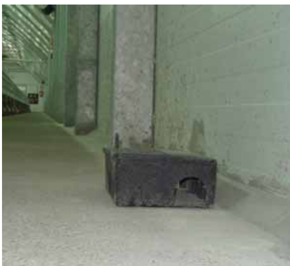
Foto 10: Debe evitarse la presencia de roedores, manteniendo las instalaciones en perfecto estado y limpias incluyendo cebos y trampas.
