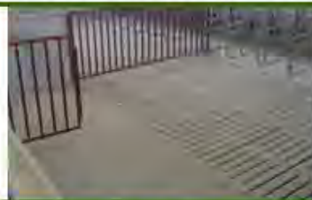
Suelo de hormigón emparrillado y sin emparrillar
