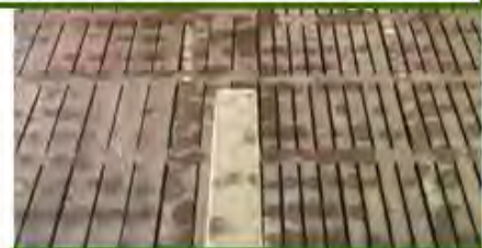
Dos tipos de emparrillado de hormigón: 160/20 y 80/20
