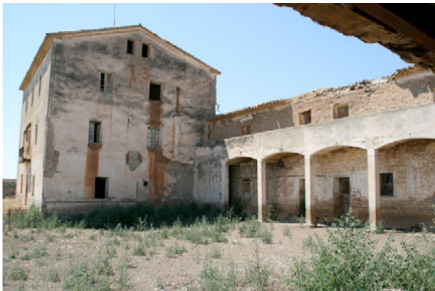
Imagen de la que fuera residencia del INC (a la izquierda), junto a la que se ubicaron las viviendas provisionales de colonos (a la derecha). (Foto: José M. a Alagón Laste)
