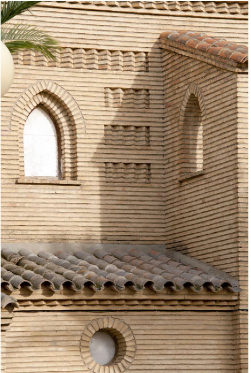
Detalle de la fachada lateral de la iglesia, donde se aprecia la decoración de ladrillo en esquinilla que enmarca las ventanas de la nave. (Foto: Fernando Alvira Lizano)
