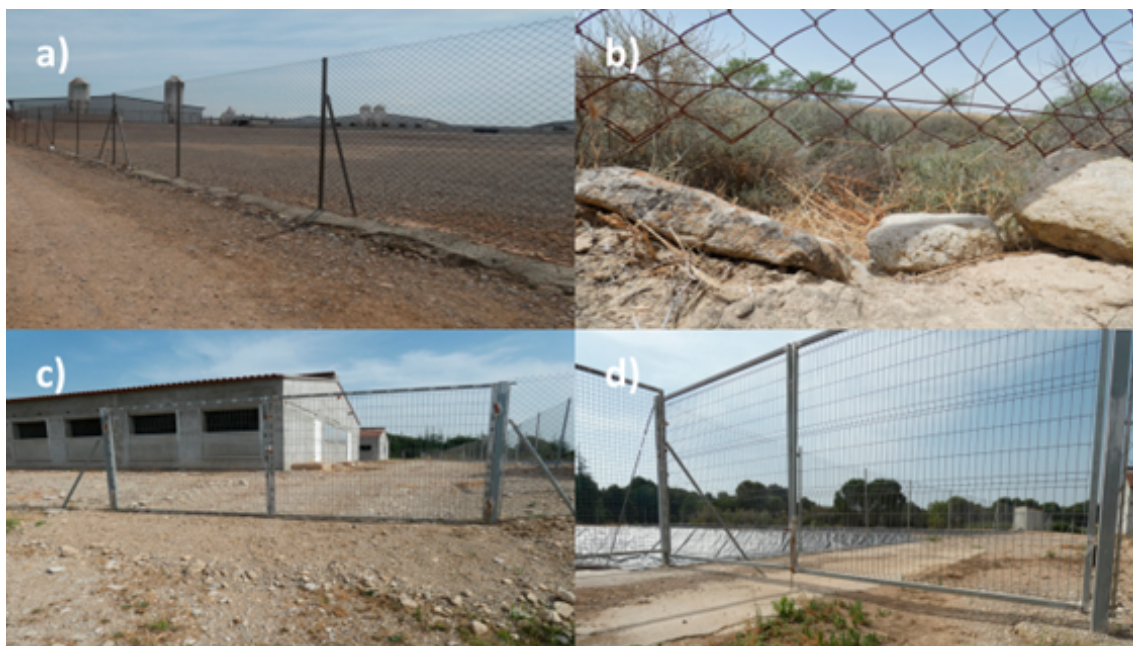
Figura 5. Tipos de vallados y accesos según su permeabilidad: a) vallado impermeable, b) vallado permeable, c) acceso impermeable, d) acceso permeable (imágenes: IREC).
