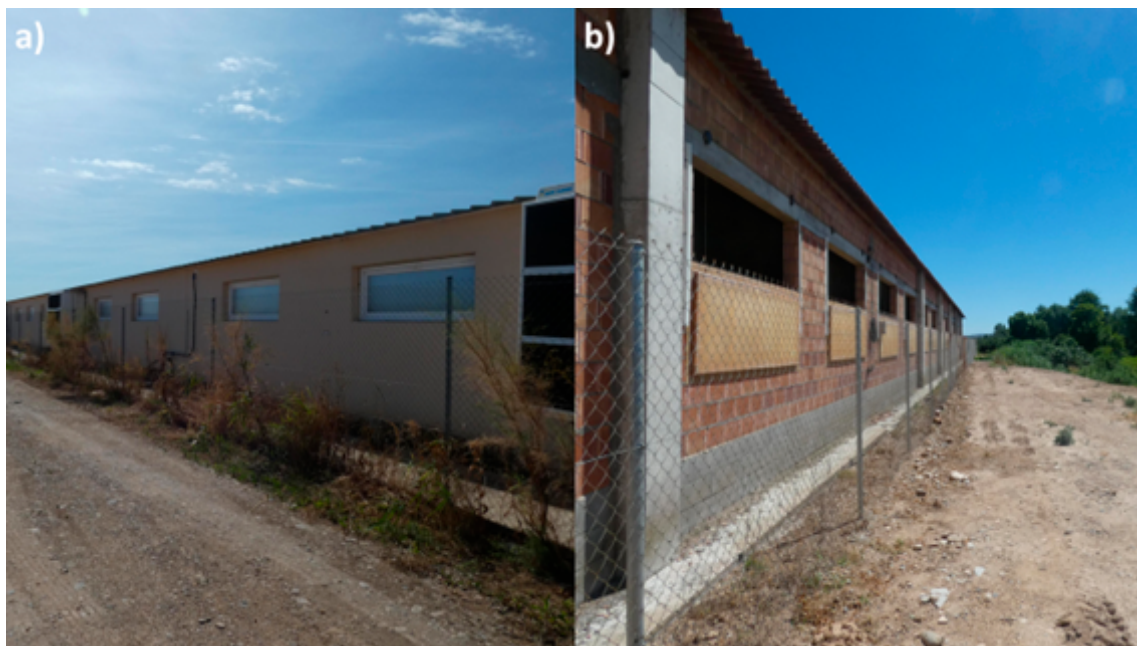
Figura 14. a) Vegetación alta en la base del vallado interior. b) Ejemplo de vallado sin vegetación alta.
