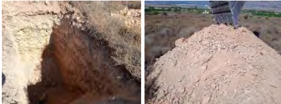
Figura nº 36. Excavación del suelo en la zona de actuación
