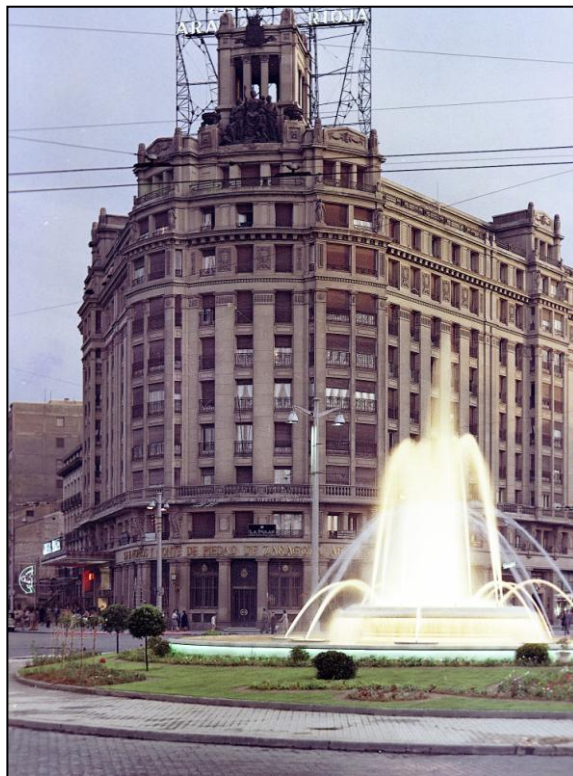
Edificio de la antigua sede de la Delegación Regional del Ebro del Instituto Nacional de Colonización, paseo de Sagasta nº 2. [AHPZ. Fondo COYNE. Núm. 174].
