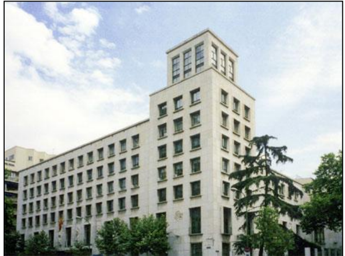
Edificio de la antigua sede central del Instituto Nacional de Colonización, en el paseo de la Castellana (Madrid).
