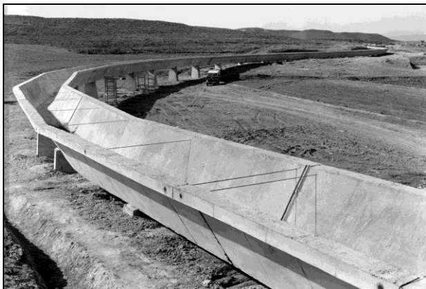
Acequia de Santa Quiteria a su paso por la finca de D. Salvador Ena. San Jorge, zona de Almudévar (Huesca) [AHPZ. Fondo COYNE. Núm. 4770].
