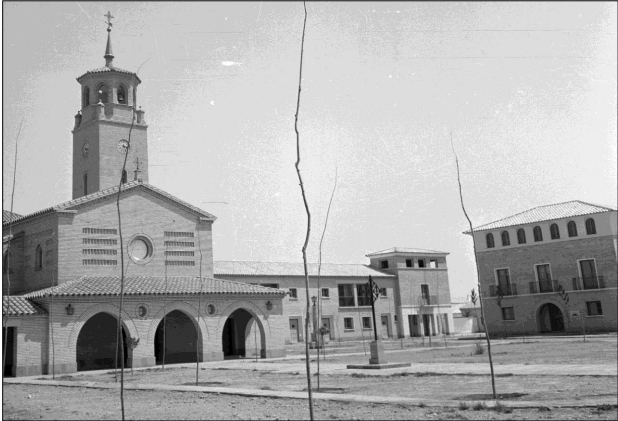
Plaza de El Temple , durante su construcción por el INC [AHPZ. Fondo COYNE. Núm. 4798].
