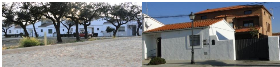
Lám. 6. Los amplios espacios alrededor de viviendas de obreros y colonos en Vegaviana están siendo pavimentados sin ningún tipo de criterio, alterando sustancialmente el concepto arquitectónico propuesto por Fernández del Amo. Tampoco la construcción de nuevas casas en los patios de las antiguas viviendas, cada vez más frecuente, constituyen el mejor ejemplo evolutivo de la vertiente arquitectónica de la colonización (Alagón del Río. Fotografías de los autores).
