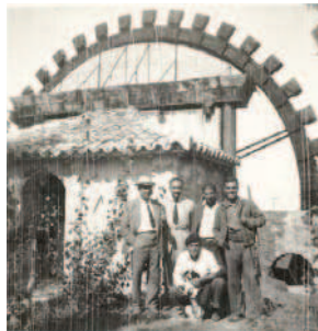
Figura 3. Noria para elevación del agua de azarbe de Tardienta. Finca Violada-Estación, hacia 1954.
