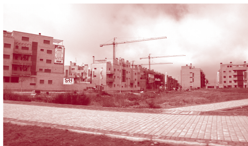
FIG. 4/ Imágenes de la operación inmobiliaria Valdeluz
