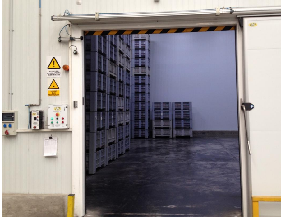
Figura 19. Cámara de desverdizado o maduración
