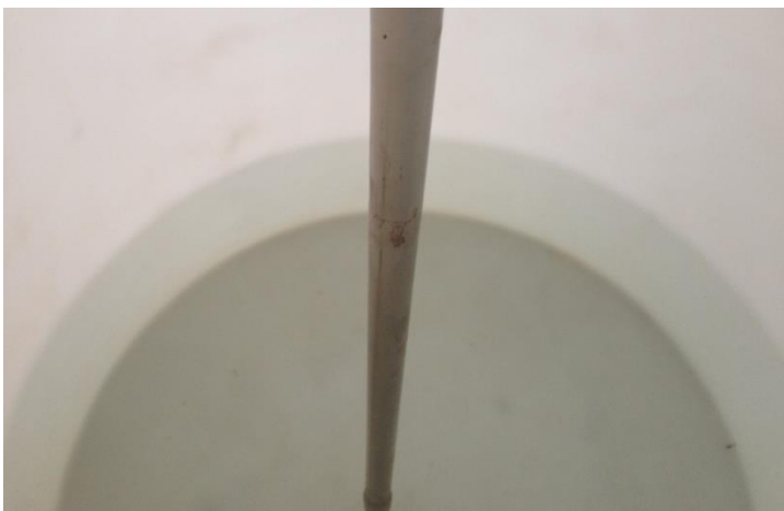
El agitador mecánico no permite una suficiente agitación del líquido del depósito.
