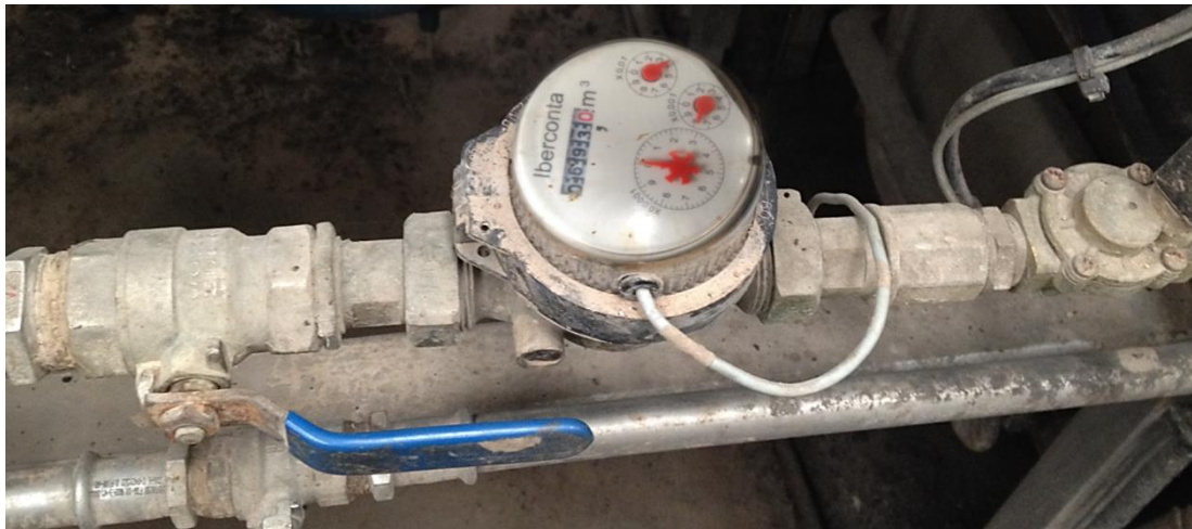
Sistema de medida del volumen de líquido.
