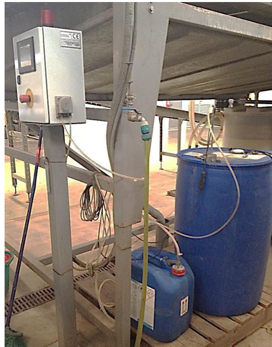
D. Ejemplo de depósito del sistema de inyección. También es un depósito principal SIN mezclado "in situ".
