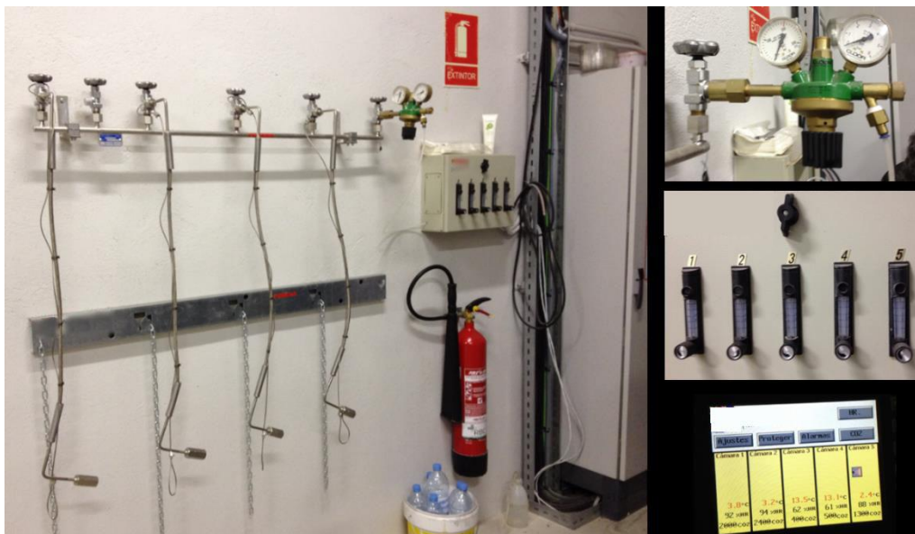
Figura 20. Sistema de dosificación de las cámaras de desverdizado y maduración
