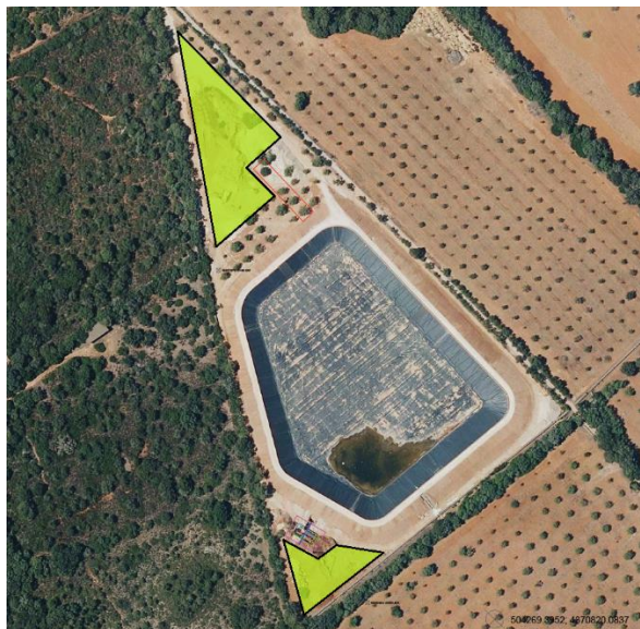
Fig. 1 Replanteo estructura vegetal.
