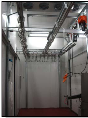
Ilustración 16 Detalle estructura matadero
