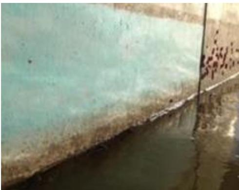
**Figura nº 21: Imprimación de repelentes en canal de riego**
