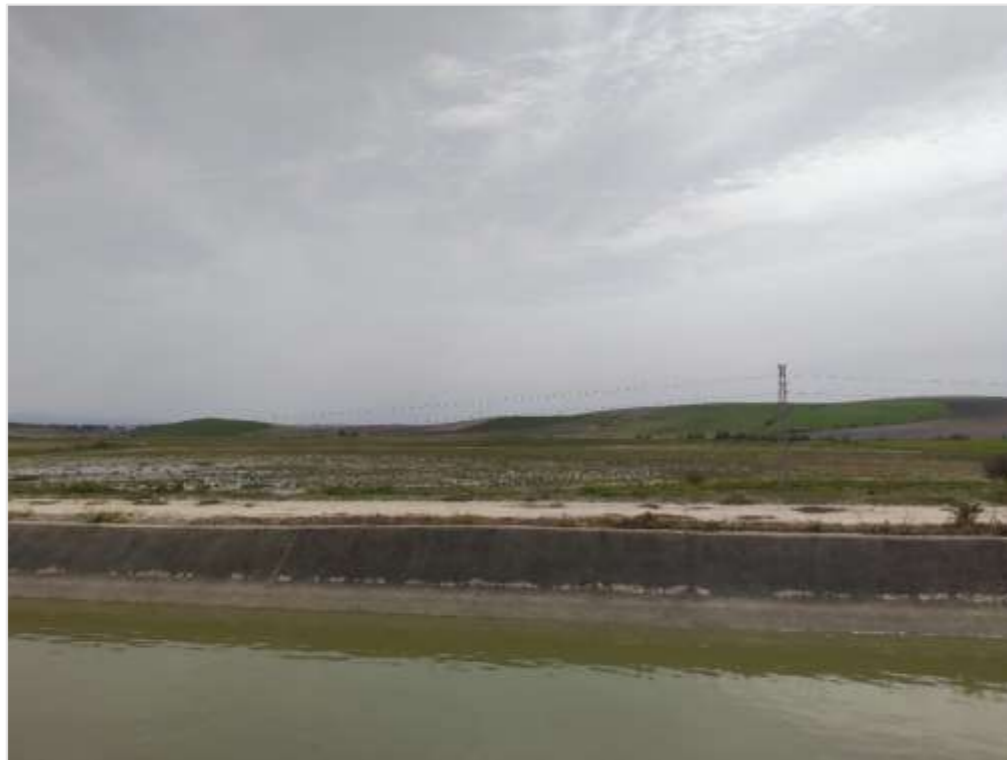
Imagen 5. Emplazamiento de la futura balsa Palmillas
