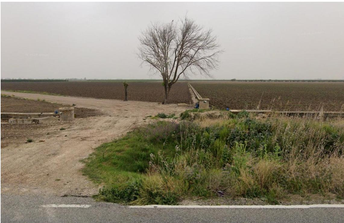
Prácticamente todo el trazado que se pretende entubar corresponde a acequias que actualmente discurren en superficie. La excepción a esto es el primer tramo de la acequia A-IV-5, cuyo punto de captación en el Canal del Bajo Guadalquivir se trasladó aguas arriba de una obra de regulación. Este tramo discurre actualmente paralelo al canal hasta llegar a la arqueta original de inicio de esta acequia, en un tramo enterrado.
