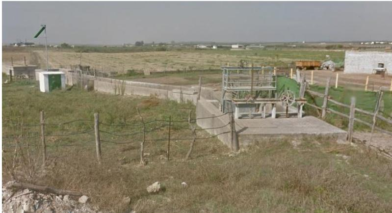
**Imagen 4. Arqueta de conexión con Canal del Bajo Guadalquivir con acequia A-V-2**
