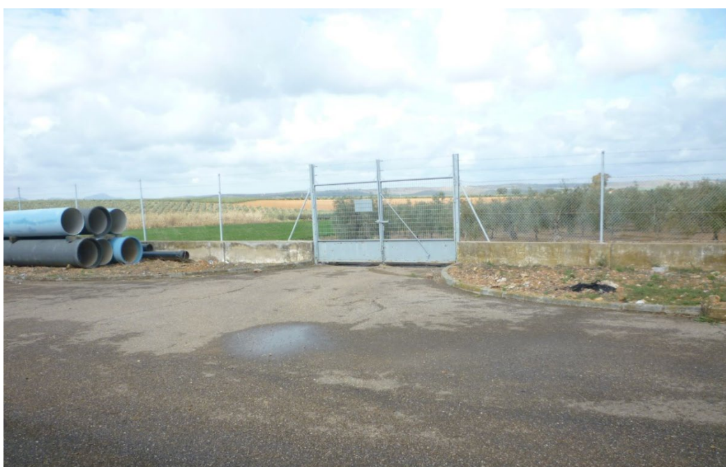
Figura 44. Interior Acceso 2 a estación de bombeo
