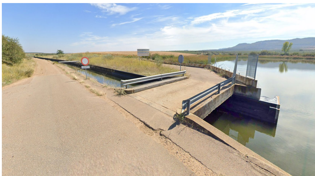
Figura 46. Paso sobre canal para acceso 3 zona este campo fotovoltaico
