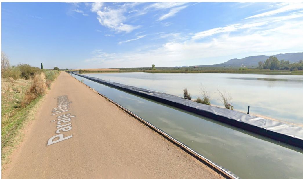
Figura 45. Camino acceso balsa de regulación 6
