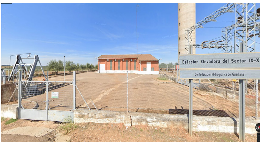
Figura 43. Acceso 1 a estación de bombeo
