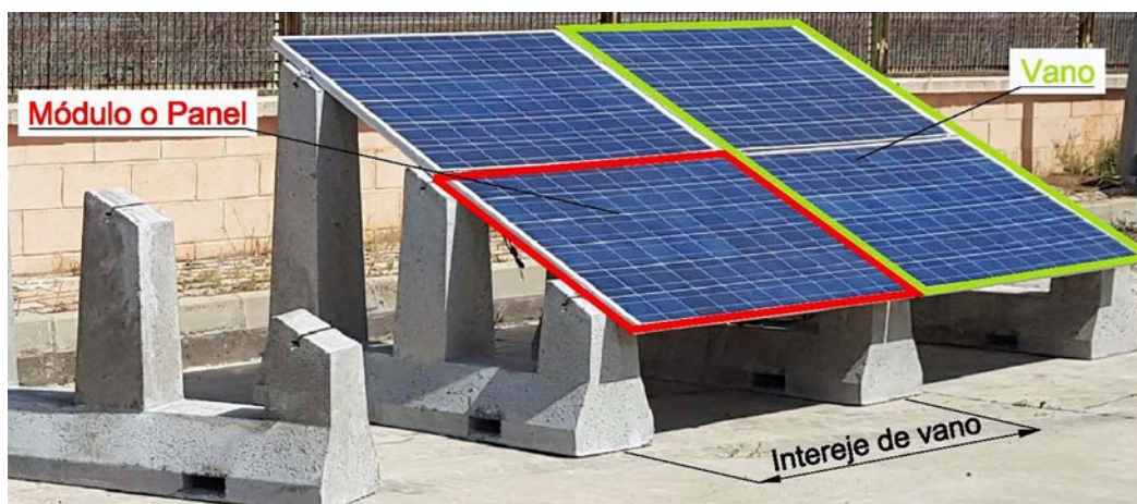
Figura 22. Disposición de placa solar sobre soportes prefabricados
