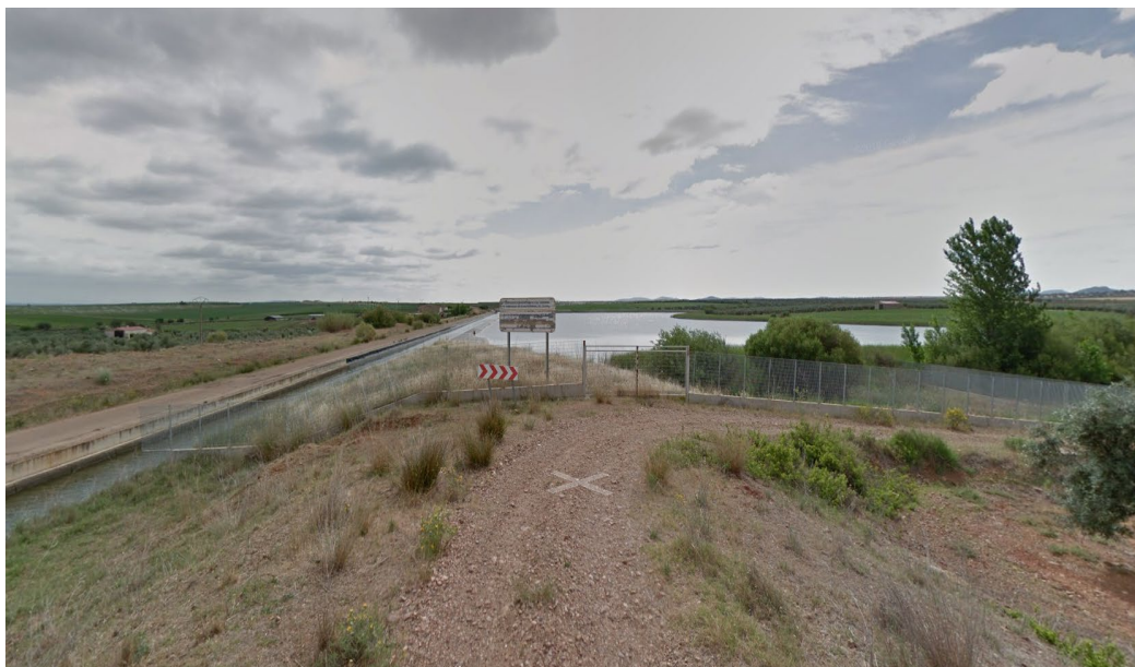
Figura 47. Camino acceso 4 zona oeste campo fotovoltaico
