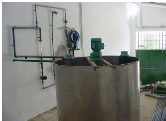
Imagen 1: ilustración de una unidad de precipitación de fosfato cálcico (apatita)
