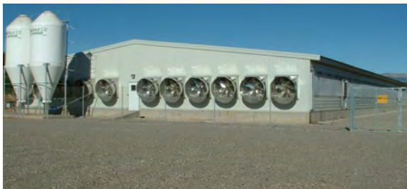
Imagen 1: grupo de ventiladores de una torre de lavado de aire.
