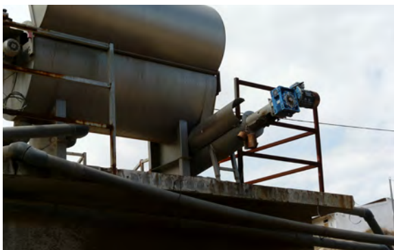
Imagen 1: separación por filtro de tambor.
