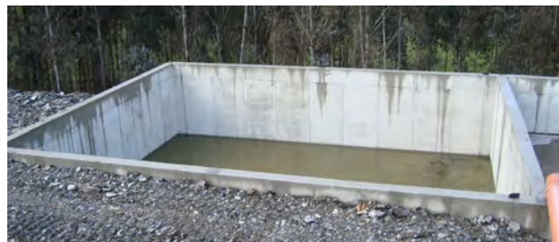
Imagen 1: tanques exteriores de almacenamiento de purines.
