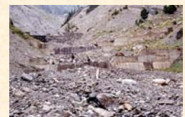
Dique en el Torrente de Senet completamente aterrado. Obra 1968. Alta Ribagorça. Vilaller. Lleida. 1984. José López Quintanilla, Alvaro Picardo y Sabas Yagüe.
