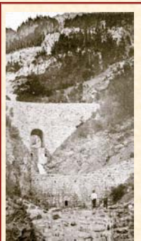
Dique del Torrente Epifanio. Canfranc, Huesca.
