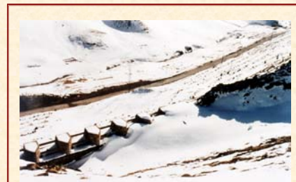
Vista posterior de un dique para contención de aludes en el Valle de Astún. Jaca, Huesca. 1991.
