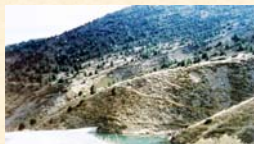
Reglamentado y con diques en el Barranco La Casassa de Mollo, Girona. Dique colmatado de sedimentos. 1980. José Luis Molina Vicente.
