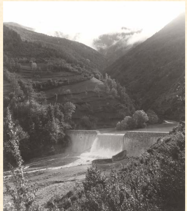
Dique en Torrente de Yosa. Broto, Huesca. 1963.
