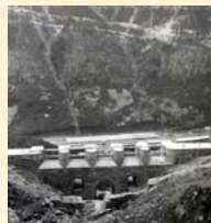
Vista desde dique rastriero en el Torrente de Estivellas de la Estación Internacional de Canfranc, Huesca. 1964.
