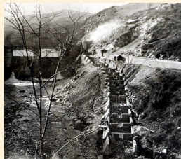
Construcción de una gran escala salmonera en un río de Cantabria.
