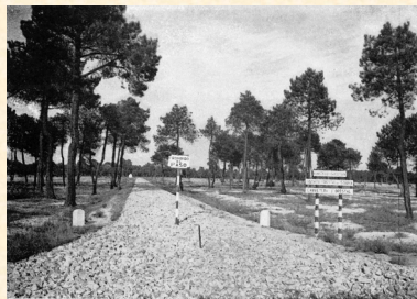
Carretera Forestal, en construcción, en un pinar de la provincia de Segovia. 1959.
