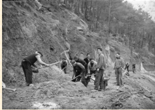
Construcción de camino en la Hoz Seca. Torete. Guadalajara. 1966.
