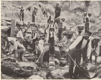
Construcción del dique del Torrente Enseu. Gerri de la Sal. Lleida. 1903.
