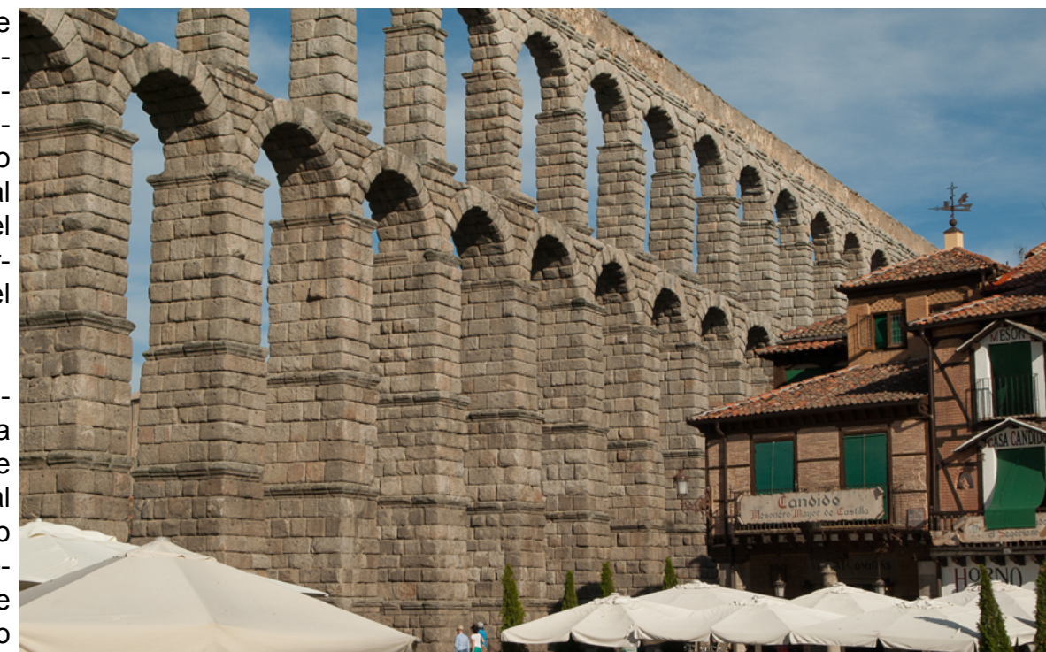
Vistas del acueducto de Segovia
