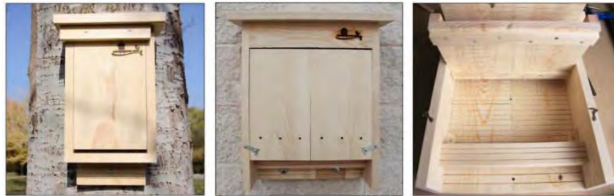
Fig. 132. Ejemplo de instalación de un refugio para murciélagos sobre un árbol y sobre una pared. La imagen de la derecha muestra su interior.
