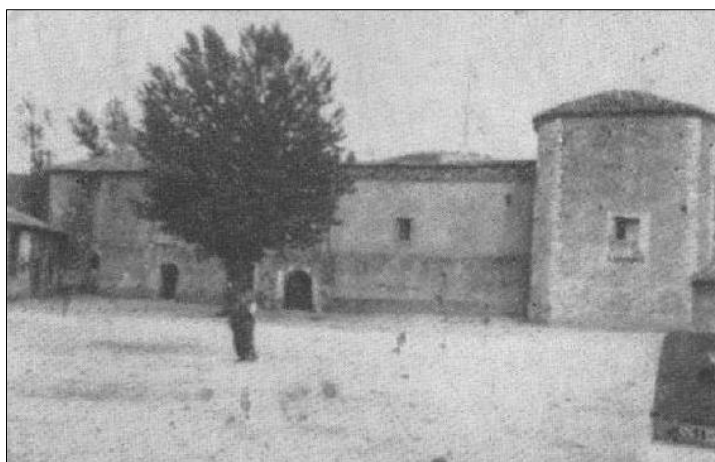
Ilustración 199: El Castillo de Vegas del Condado poco antes de su demolición en 1959.
