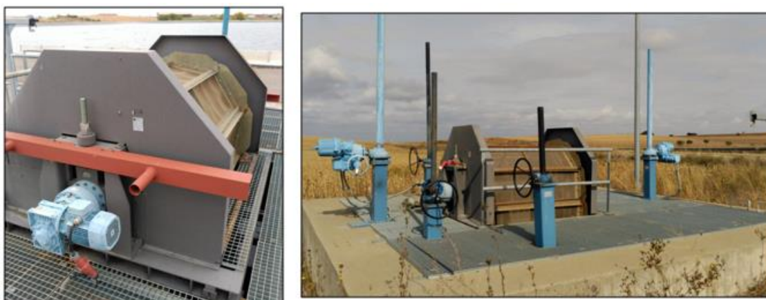
Ilustración 11: Ejemplos de filtros rotativos de mallas instalados en otras zonas regables próximas a la CRR.
