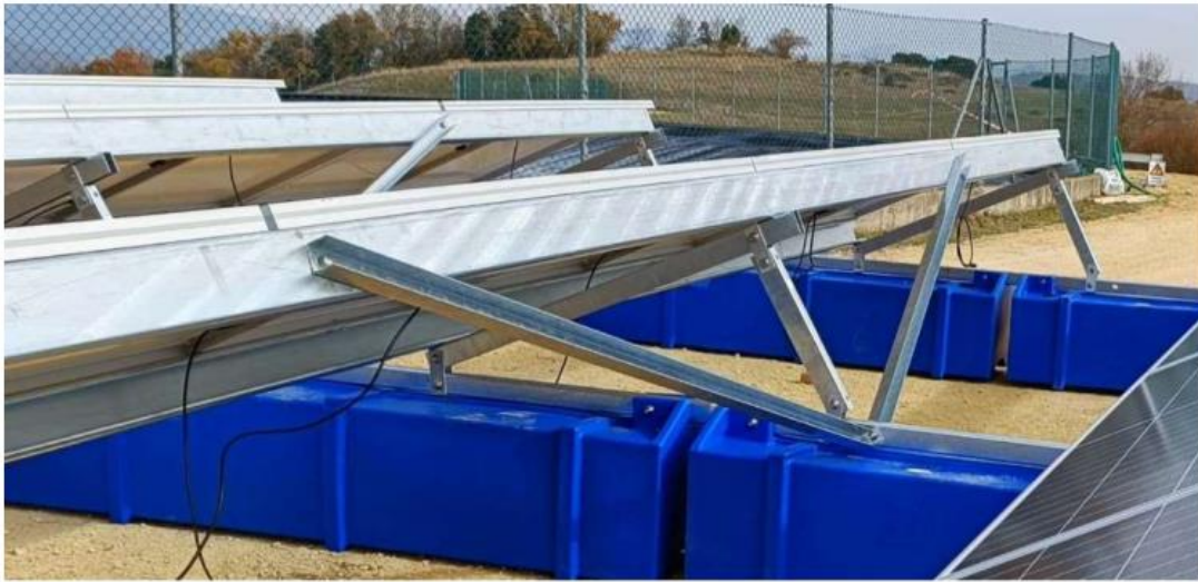
3.- Montaje de los paneles fotovoltaicos sobre la estructura flotante.
