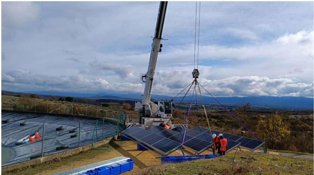
6.- Izado de un string para ser colocado dentro de la balsa.
