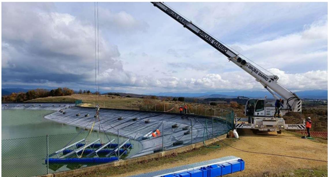
7.- Colocación del string en la balsa.
