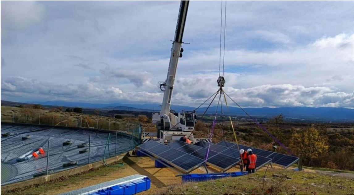
**Ilustración 12.** Izado de un string para ser colocado dentro de la balsa
