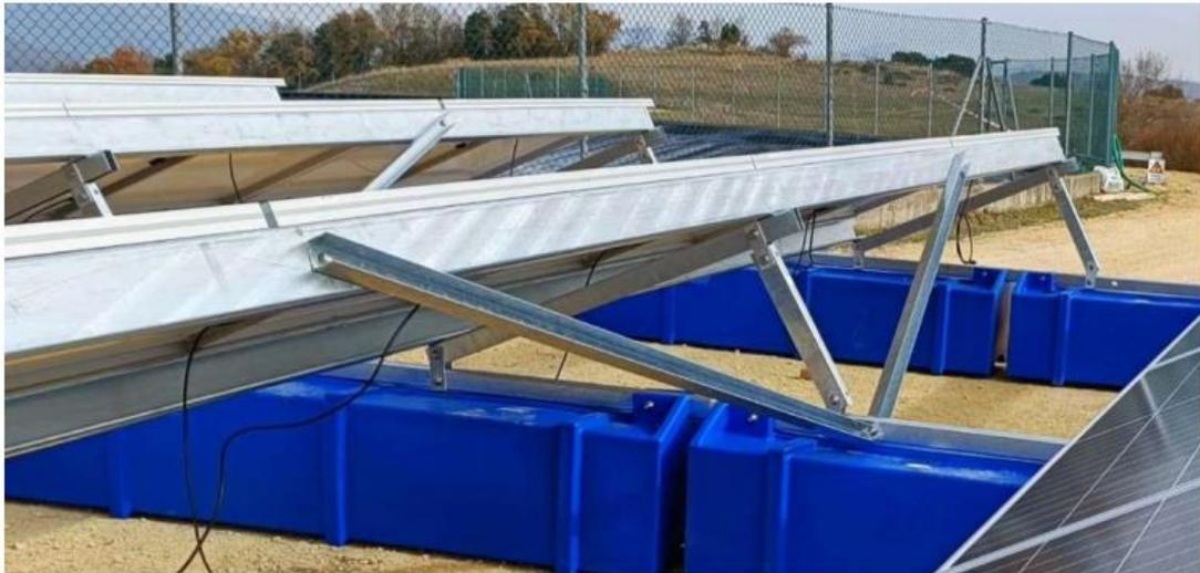
**Ilustración 9.** Montaje de los paneles sobre la estructura flotante
