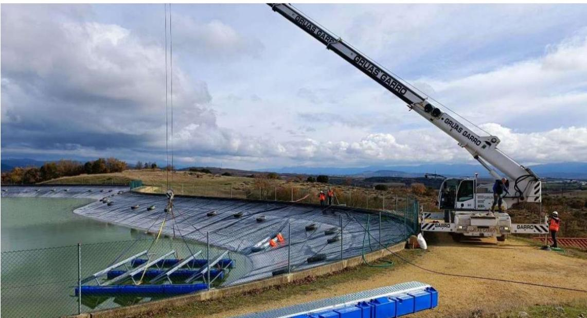
**Ilustración 13.** Colocación del string en la balsa
