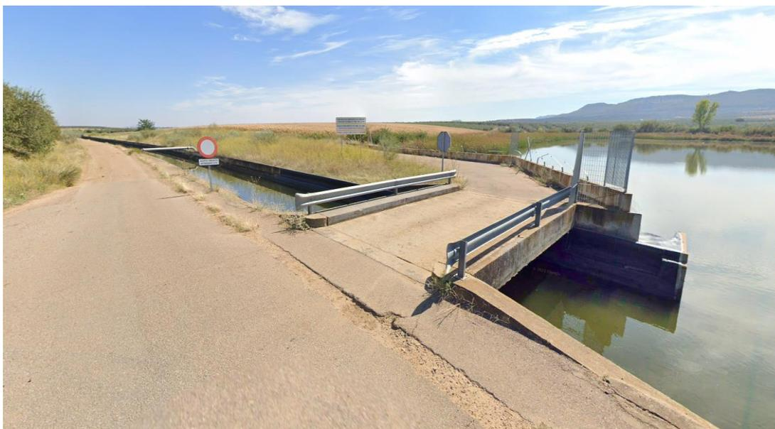
**Fotografía 5.** Paso sobre canal para acceso 3 zona este campo fotovoltaico
