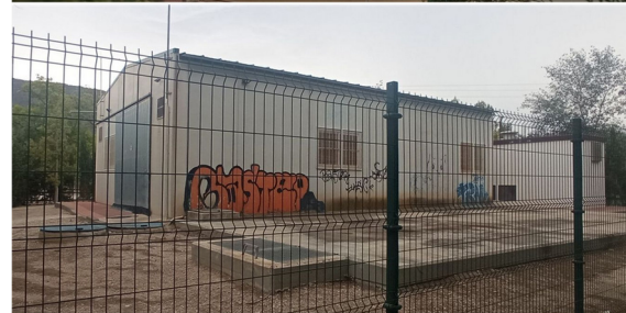
Estación de bombeo
