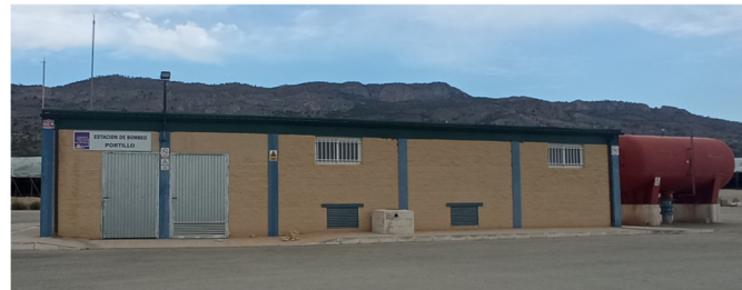
Estación de bombeo
