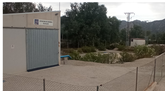
Estación de bombeo
