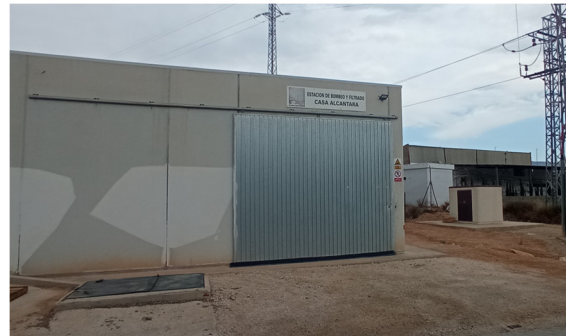
Estación de bombeo
