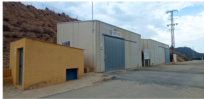
Estación de bombeo
