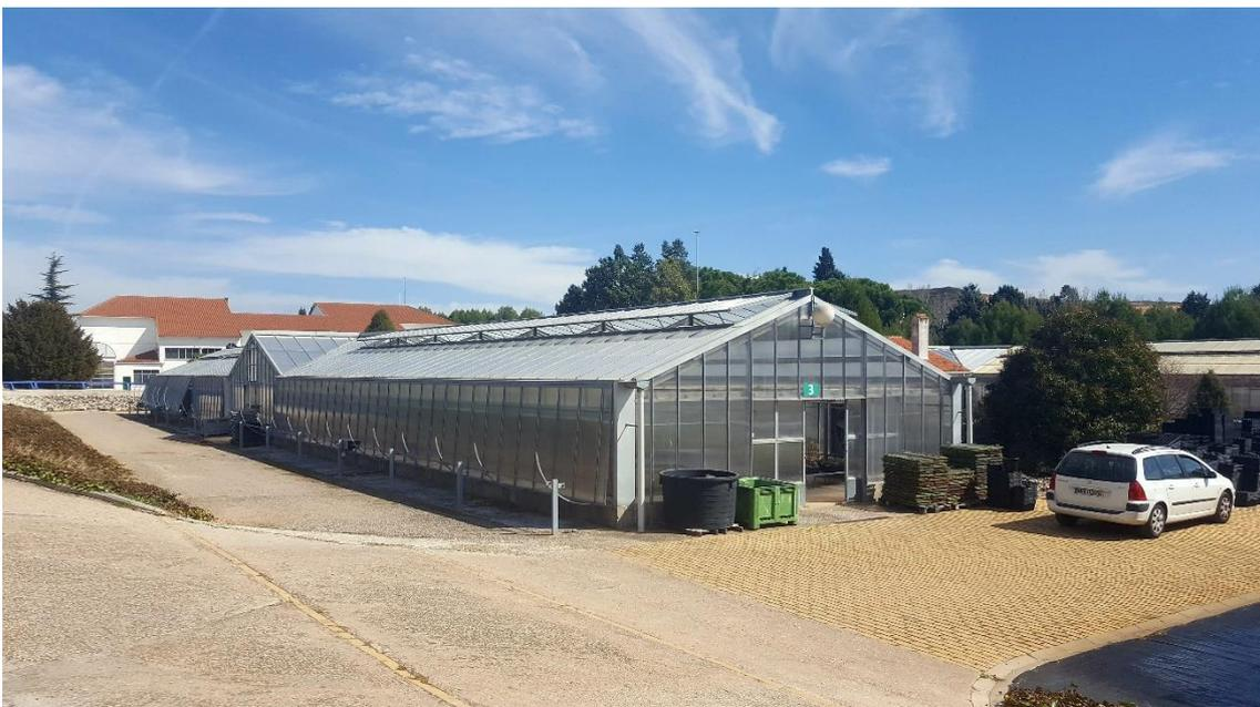
**Ilustración 51 Detalle paramentos verticales de policarbonato en invernadero**
