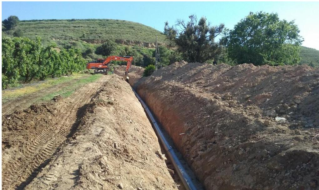
**Ilustración 45 Instalación tubería pvc red “alta”**
