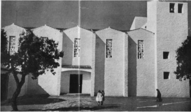
FIG. 4. Muros laterales y vidrieras. Iglesia de Vegaviana.
