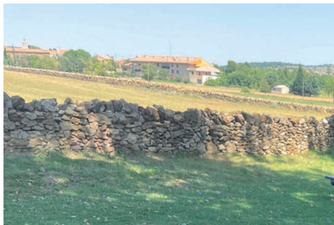
Muro de piedra seca en explotación de tierra de cultivo de secano.
