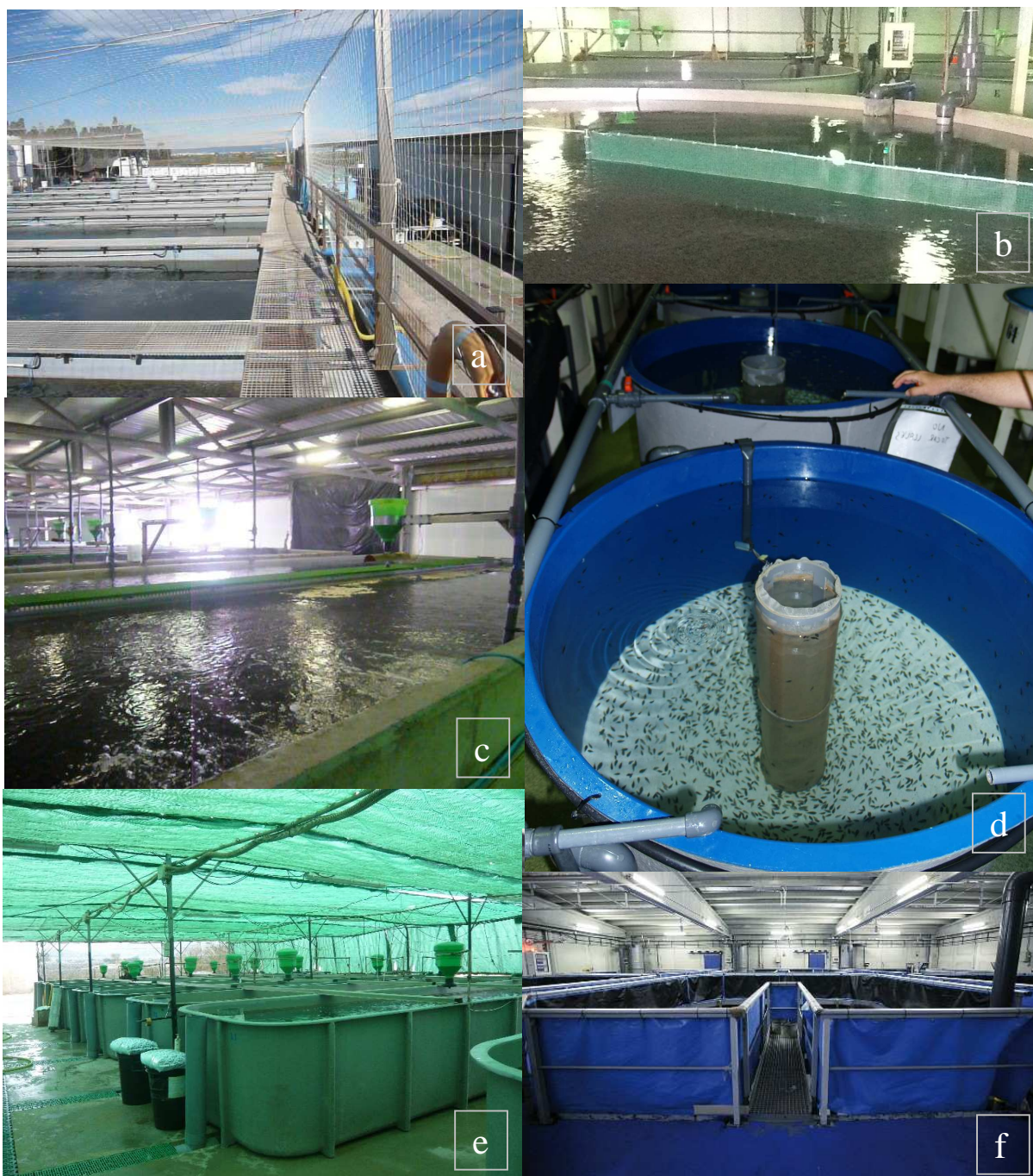
Figura 23. Instalaciones de Acuicultura en tierra firme. Diferentes configuraciones de tanques e instalaciones. a) Balsas al aire libre para preengorde de juveniles. b) Balsas circulares con pantalla para forzar cambios en el desplazamiento de los ejemplares. c) Balsas rectangulares para engorde intensivo. d) Tanques circulares para la cría de juveniles. e) Tanques móviles de material plástico para preengorde en exteriores. f) Balsas de geotextil flexible recambiable sobre estructura metálica de soporte.
