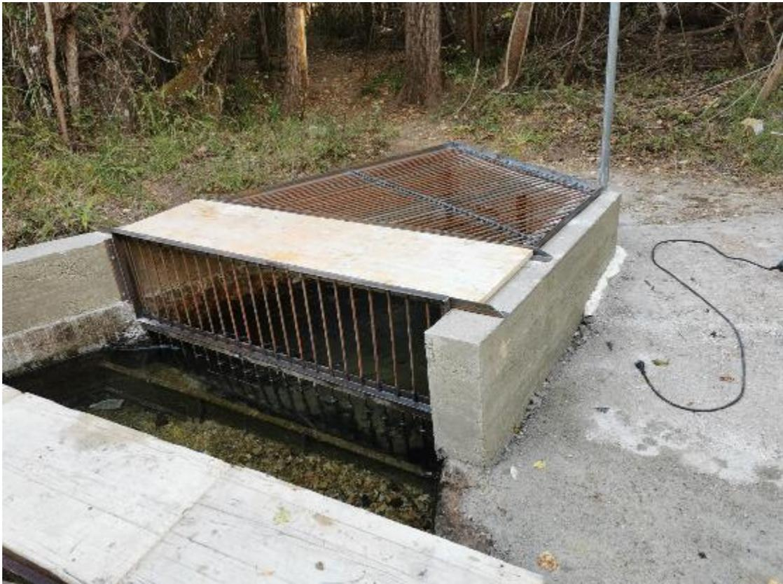
Fig. 1 - REJILLAS DOBLES EN LA TOMA DEL AGUA.
