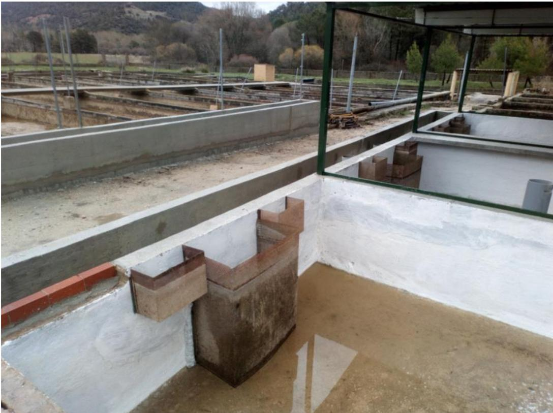
Fig. 4 – INSTALACIÓN DE REJILLAS NUEVAS EN ESTANQUES.
