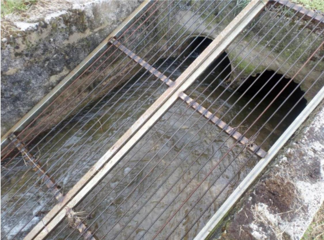
Fig. 7 - REJILLA FINAL EN CANAL DE SALIDA AL RÍO
