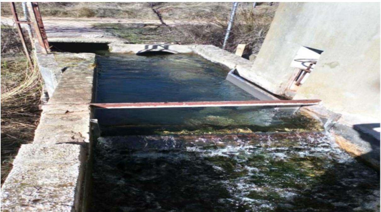
Fig. 2 - COMPUERTA DE ENTRADA
